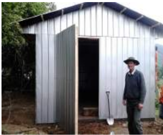
BODEGA SECTOR LOS HUALLES
