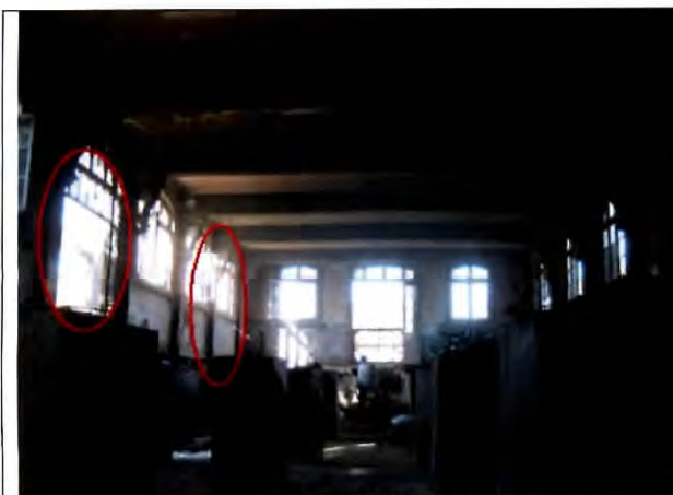
Fotografía N° 8 Vista de vidrios quebrados con peligro de caída de trozos.
