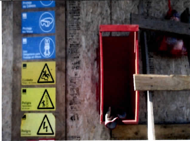
Fotografía N° 10: Ausencia de extintor en lugar dispuesto para su colocación.
