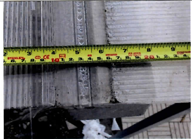
Fotografía N° 3: Unión ejecutada de perfiles metálicos en cobertizo e imagen del plano estructural Lámina EST 3 de 3, donde se indican las piezas y soldadura para la unión de perfiles.
