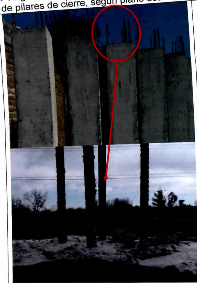
Fotografía N° 7: Vista general de los pilares de hormigón del cierre perimetral sector nororiental e imagen plano estructural lámina EST 1 de 3 con ubicación y cantidad de pilares de hormigón según proyecto.
