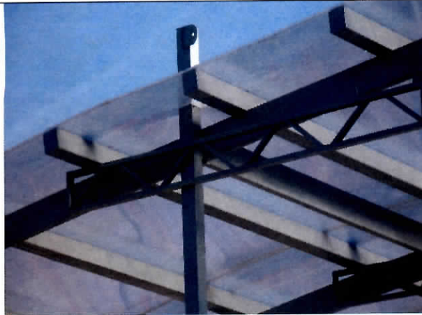
Fotografía N° 3: Unión ejecutada de perfiles metálicos en cobertizo e imagen del plano estructural Lámina EST 3 de 3, donde se indican las piezas y soldadura para la unión de perfiles.
